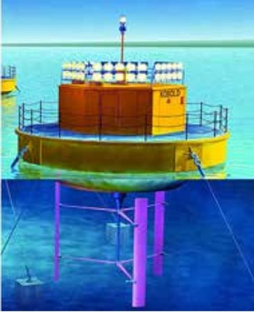
La turbina ad asse verticale Kobold installata nel 2001 nello stretto di Messina e collegata per un certo periodo alla rete ENEL è sfortunatamente rimasta un prototipo (dall'archivio della sezione ATENA La Spezia).
