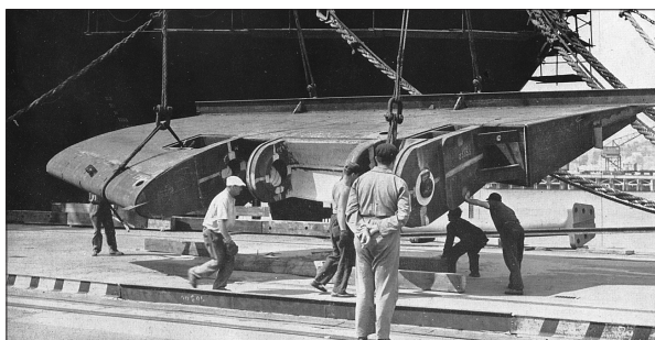
Posa del timone della “Agrigentum” sulla nave galleggiante
